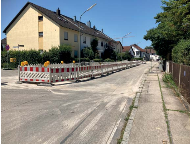
Vor Beginn der eigentlichen Arbeiten muss die Baustelle eingerichtet werden
