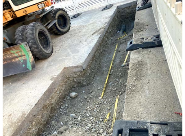
Unter der Asphaltdecke liegen viele Leitungen – etwa für Strom, Gas, Wasser und Telekommunikation
