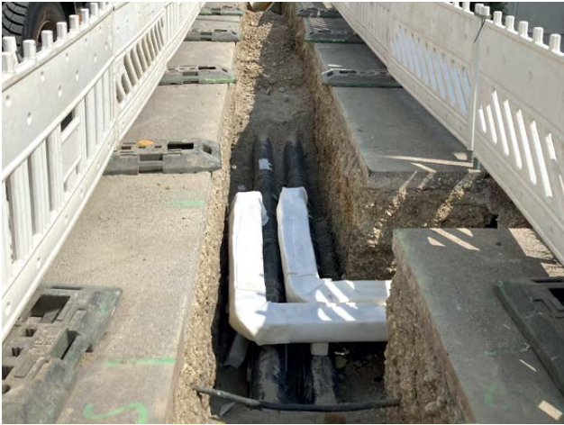
Die Rohre für die Fernwärmeversorgung werden vor dem Schließen der Baustelle gut isoliert
