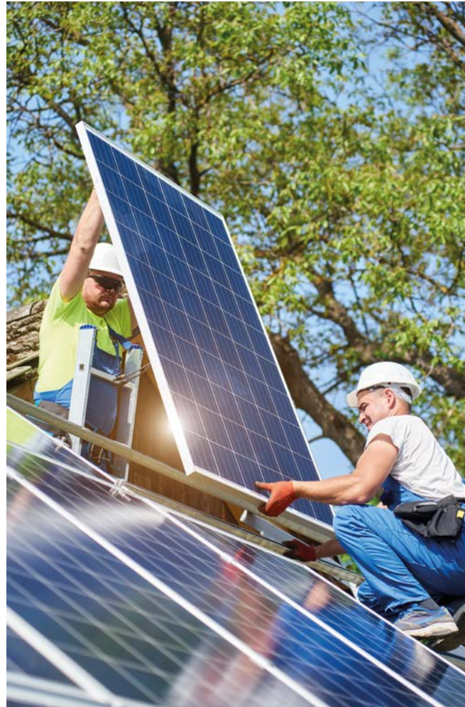
Erfahrene Kooperationspartner sorgen dafür, dass der Einbau der Fotovoltaikanlage gelingt
