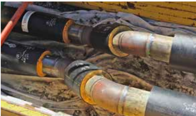
Theoretisch sollten dort, wo im Bestandsplan keine Leitungen verzeichnet waren, auch keine liegen. In der Praxis mussten drei Mal Leitungen mittels individueller Rohretagen überbrückt werden.
