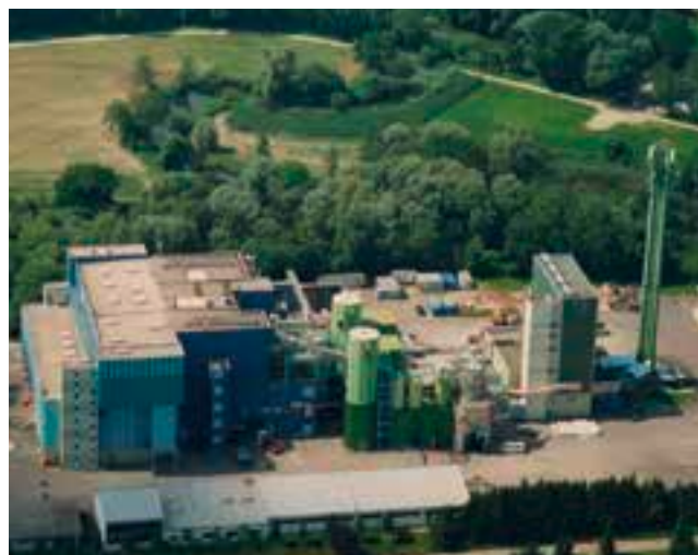
Das Abfallheizkraftwerk in Olching erzeugt Wärme und Strom ohne Mehraufwand. Seine Leistung ist kontinuierlich gestiegen. Die Verfügbarkeit der Fernwärmanlage hier liegt bei 99,99%.
